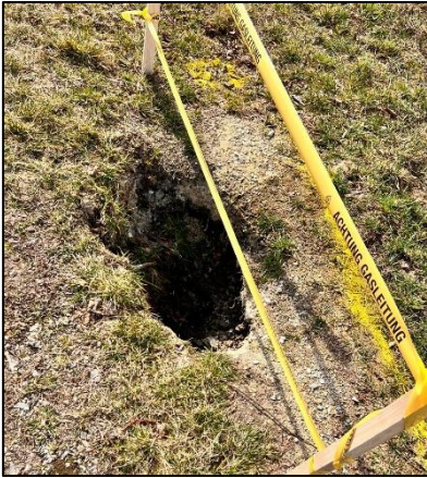
Abb. 1: Einbruch einer Röhre des Bibers
