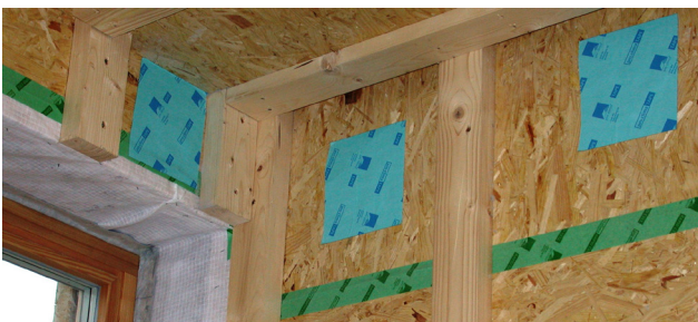
Sorgfältiges Abkleben mittels Dichtband
