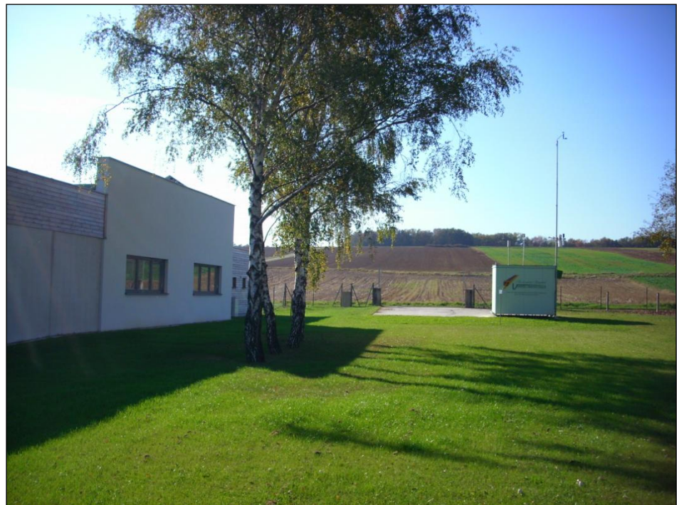
Abbildung 8: Messstelle Oberschützen von Norden (© Amt der Burgenländischen Landesregierung).
