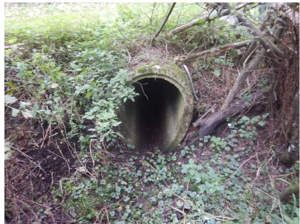
Abbildung 17: Rohrdurchlass
