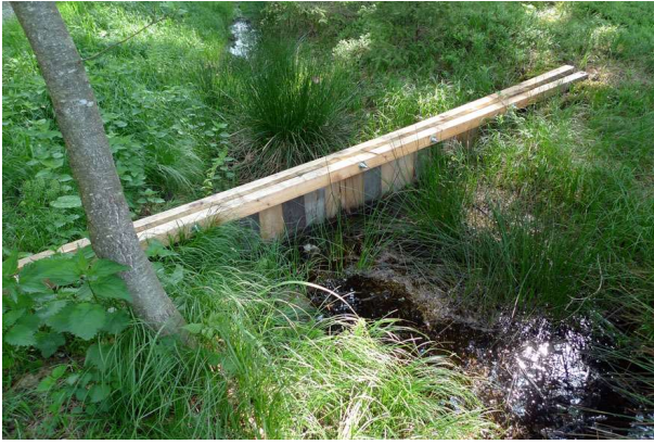
Abbildung 19: Spundwand Lichtenwalder Moor Bad Waltersdorf
