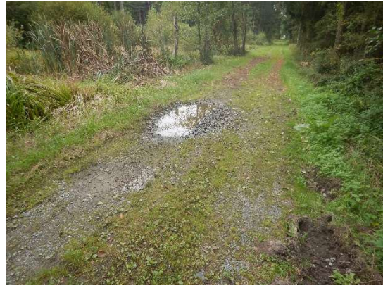
Abbildung 20: Forststraße mit Dammwirkung
