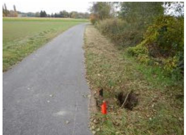
Röhreneinbruch an der Uferböschung und Unterminierung des Radweges in Markt St.Martin am Stoober Bach (Foto: Trixner C, Okt.2016)
