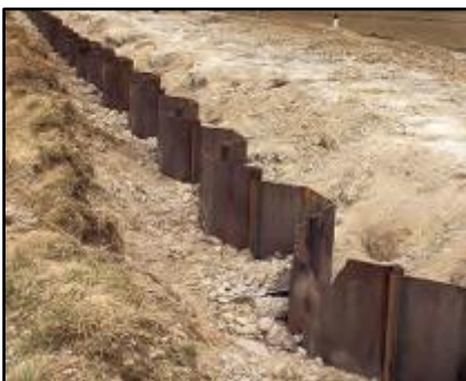
Abb. 5: eingebaute Spundwand (Quelle: Hölzler et al., 2019)
