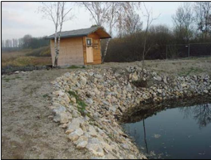
Abb. 3: Komplette Uferversteinung mit darunterliegendem Gitter (Quelle: Hölzler & Parz-Gollner, 2019)
