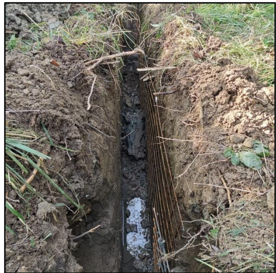
Abb. 4: Vertikal eingebautes Baustahlgitter im Teichdamm (Quelle: Gerald Kinelly)
