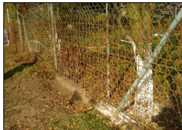
Abb. 7: Verstärkung des Zauns mit Baustahlgitter (Quelle: Hölzler & Parz-Gollner, 2019)
