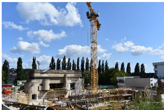
Umbauarbeiten am ehemaligen Kulturzentrum Mattersburg (Stand: Juli 2020)
