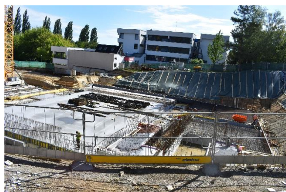
Umbauarbeiten am ehemaligen Kulturzentrum Mattersburg (Stand: Juli 2020)
