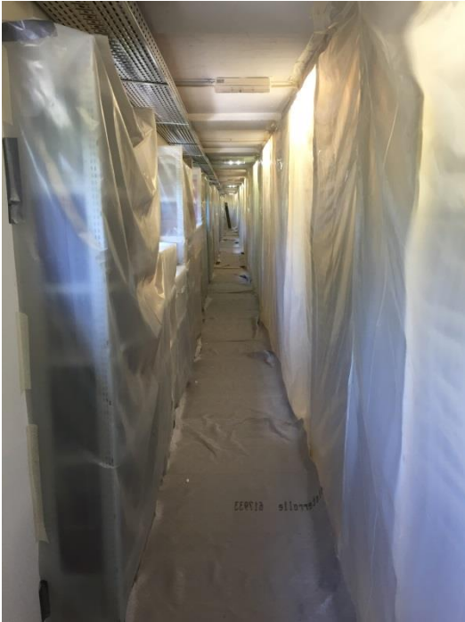
Depot der Landesbibliothek während der Sanierungs- und Umbauarbeiten
