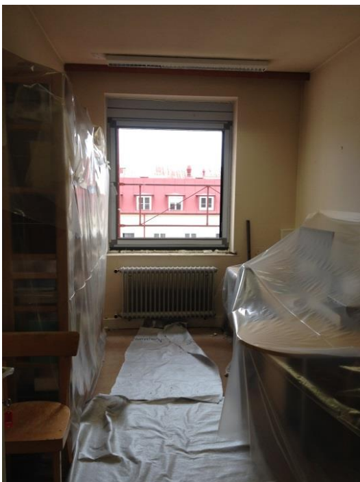
Fenstertausch bei laufendem Bürobetrieb
