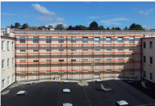
Aufbringung des Wärmedämmverbundsystems an der Südfassade
