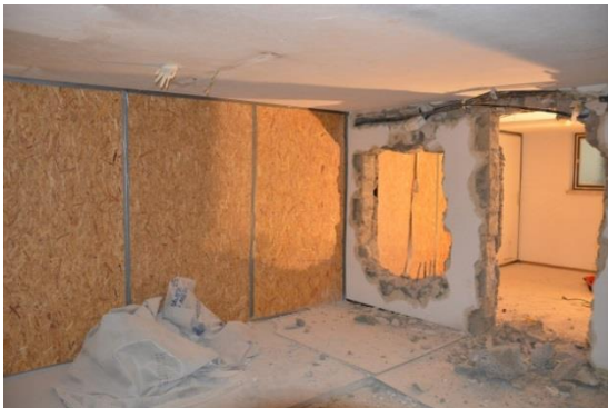
Abriss einer Mauer im ehemaligen Zeitungsarchiv der Landesbibliothek
