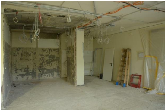
Abbruch der alten Sanitäranlagen vor dem Archivsaal im 3. Obergeschoß
