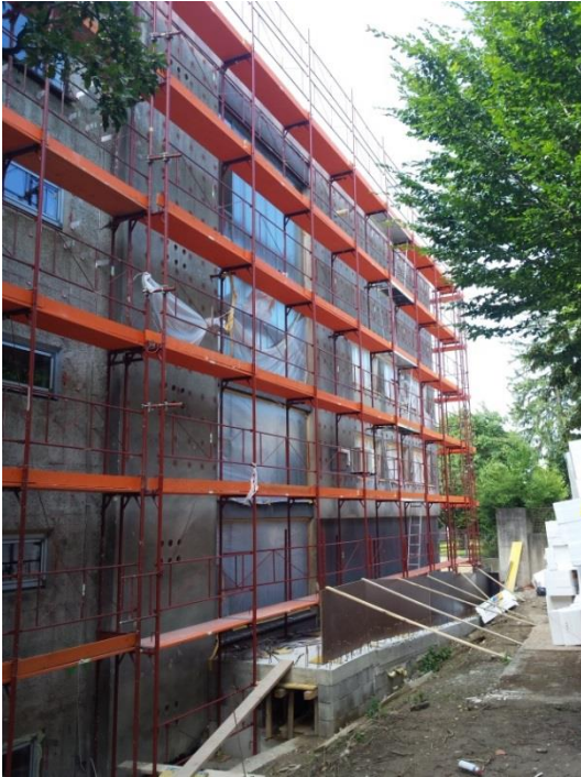
Neuerrichtung einer hinterlüfteten, dauerhaften Metallfassade an der Nordfassade
