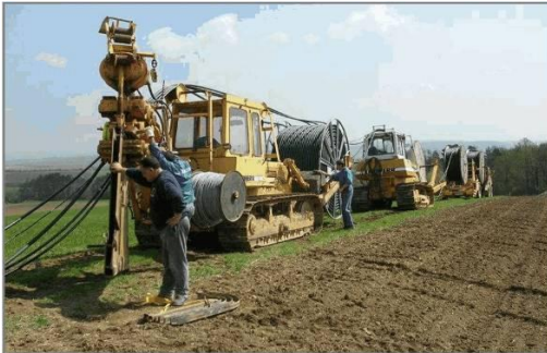
Pflug-Tross: Verpflügung direkt von den Kabeltrommeln
