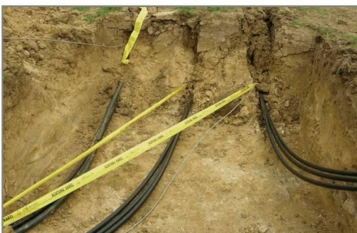
Übergang Pflugverlegung - Künette
