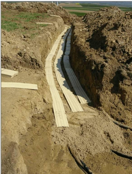
Verlegung durch Graben einer Künette
