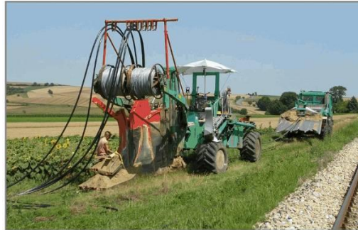
Pflug-Tross: Verpflügung mit ausgelegten Kabeln
