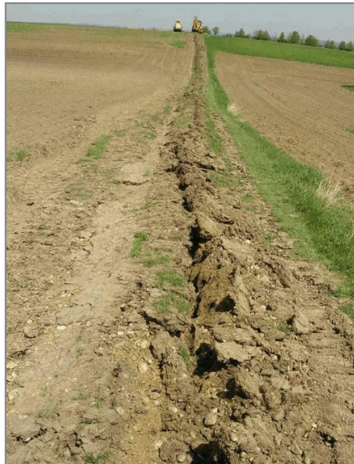
Pflugverlegung: Der Eingriff ist vergleichsweise gering
