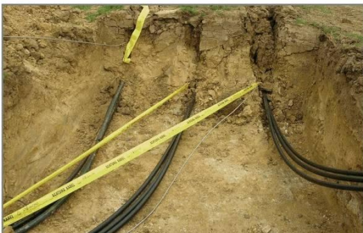
Übergang Pflugverlegung - Künette
