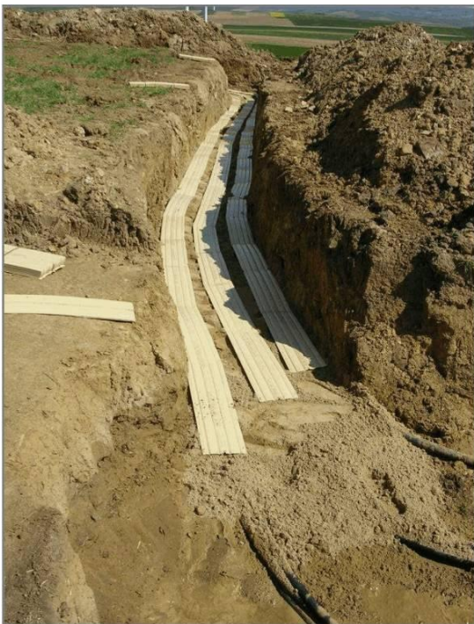
Verlegung durch Graben einer Künette
