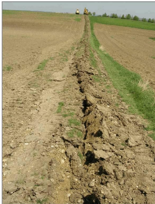
Pflugverlegung: Der Eingriff ist vergleichsweise gering
