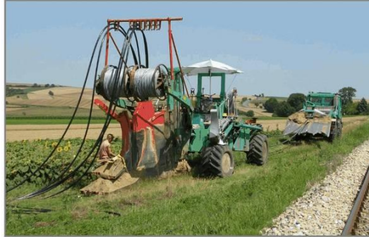
Pflug-Tross: Verpflügung mit ausgelegten Kabeln
