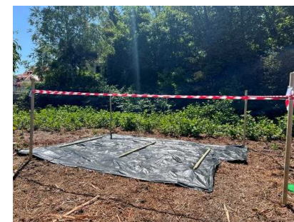
Abdeckung mit UV-stabiler Gewebeplane
