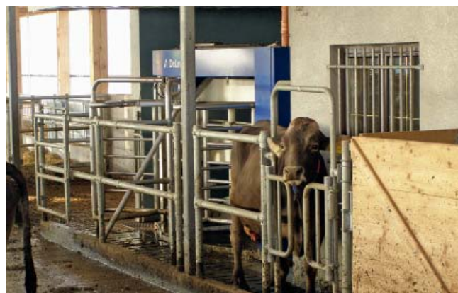
Bild 4: Der Austriebsgang sollte mindestens eine Kuhlänge betragen.
