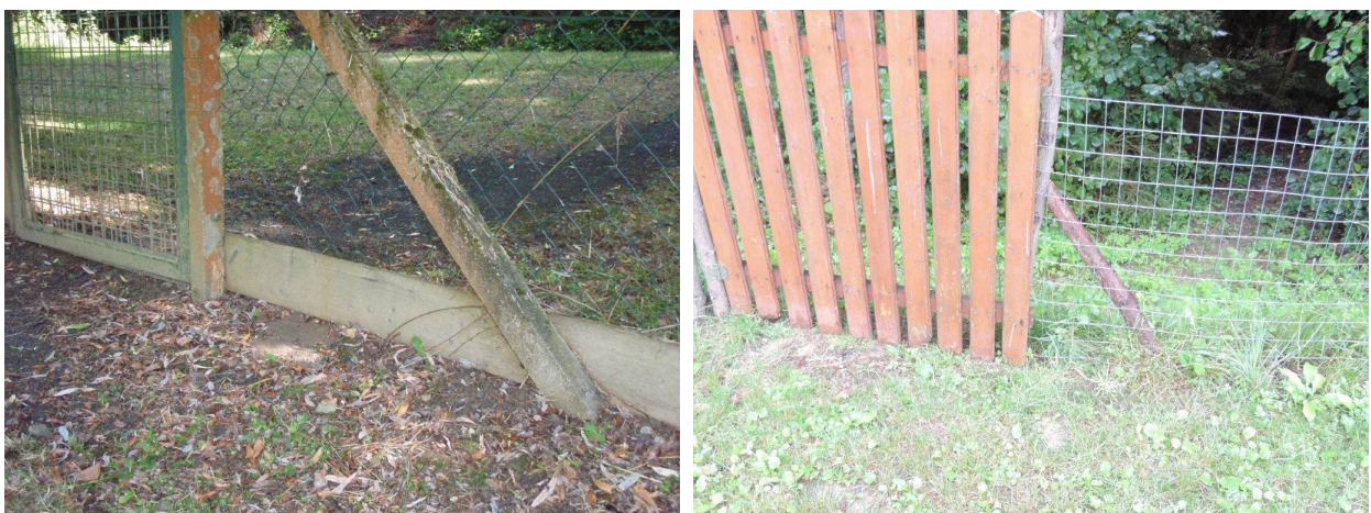
Abb. 6 Beispiele für Maschengeflechte ohne Strom (links loses Geflecht, rechts punktverschweißt); in beiden Fällen ist ein otterdichter Abschluss zum Boden auch im Bereich der Zauntore gegeben, was besonders wichtig.
