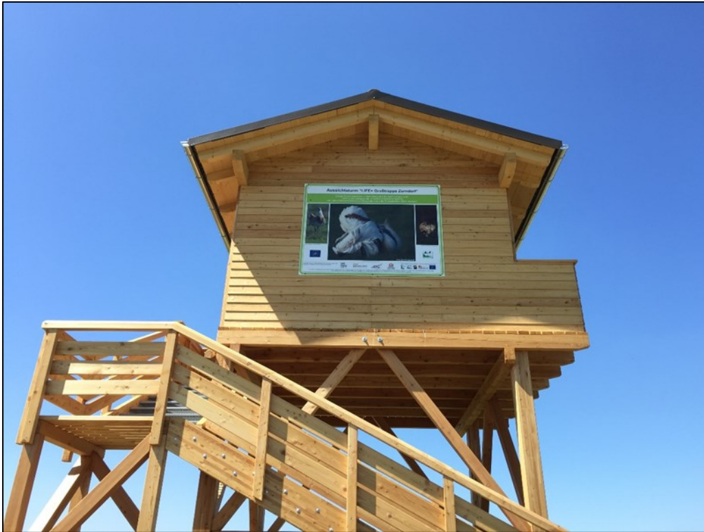
Abbildung 91: Aussichtsturm für die Großtrappe bei Zurndorf.
