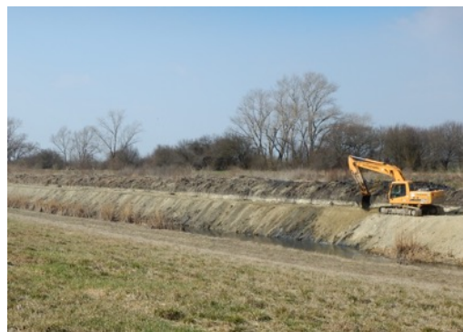
Abbildung 22: Wasserbauliche Instandhaltungsmaßnahmen am Einserkanal (Ungarn)
