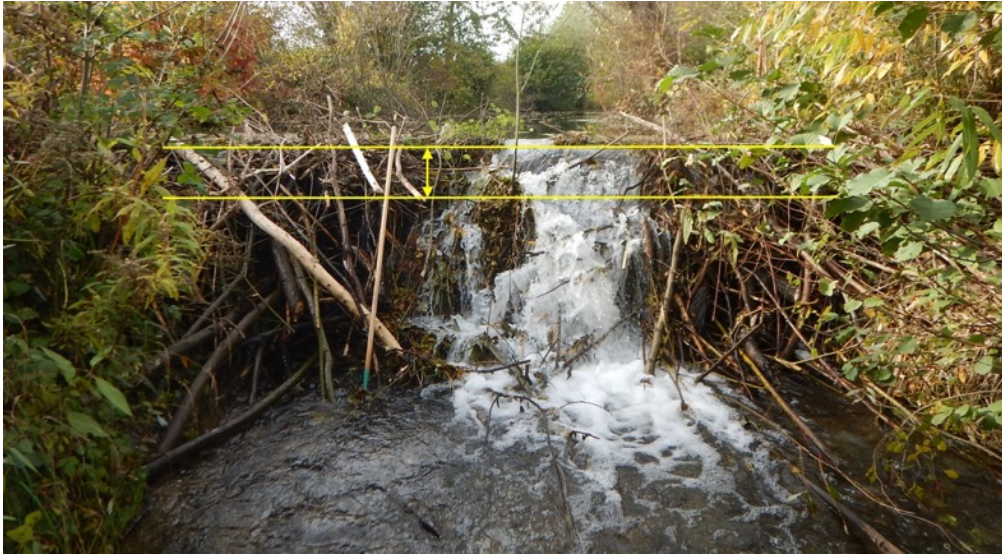
Abbildung 17: Wohndammabsenkung (= Reduktion der Dammhöhe auf gesamter Länge) – bausichernde Wirkung bleibt erhalten
