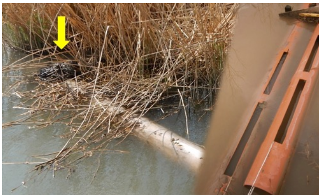
Abbildung 11: Verstopfter Rohreinlauf einer Dammdrainage; Rohreinlauf mit Schlitzten (Foto: P.Larch /Mitte, B. Schütz /rechts)
