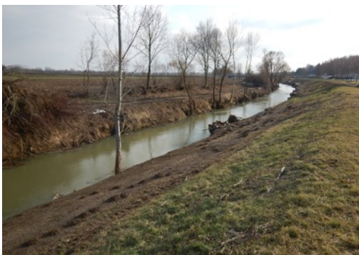
Abbildung 21: Wasserbauliche Instandhaltungsmaßnahmen an der Pinka
