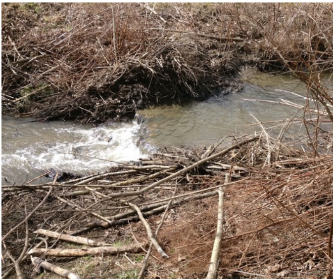
Abbildung 10: Dammentfernung (Foto: Gemeinde Kobersdorf)
