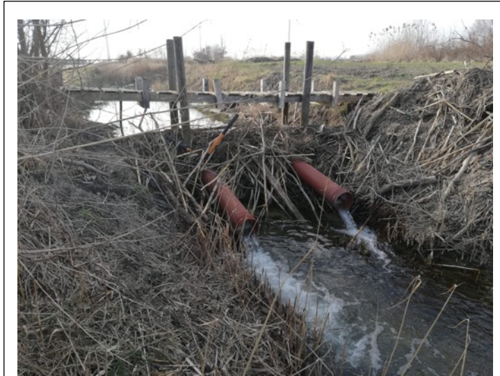
Abbildung 9: Dammdrainage mit Schlitzen (Foto: Schütz B.)
