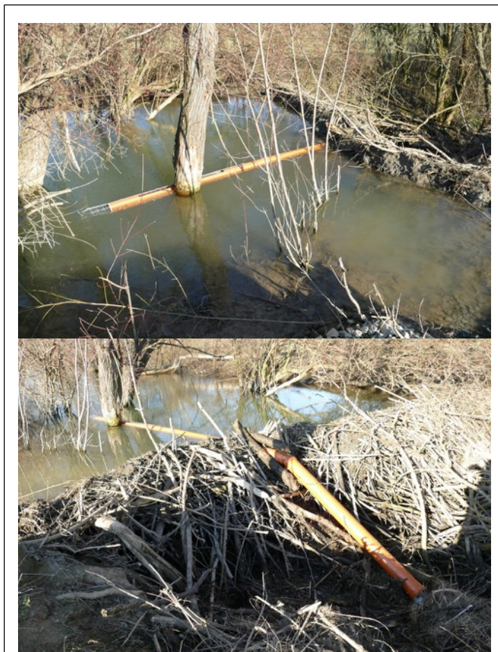
Abbildung 8: Dammdrainage mit Schlitzten (Foto: Schuh K.)
