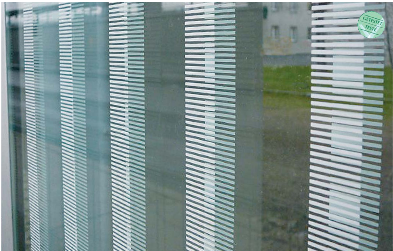
Eine Detailaufnahme der oben abgebildeten Wand. Der Siebdruck – 2 cm breite unterbrochene Streifen in 10 cm Abstand – wurde beidseitig aufgebracht und teilweise auf der Rückseite etwas verbreitert, was bei Annäherung den 3D-Effekt verstärkt.
