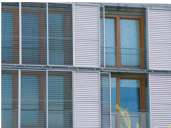
Diese seitlich verschiebbaren Jalousien schützen vor Überhitzung und verhindern Vogelkollisionen.
