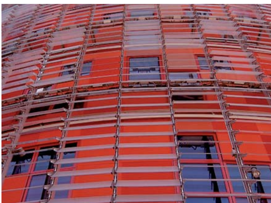
Der rundum mit Brise Soleil verkleidete Torre Agbar in Barcelona.
