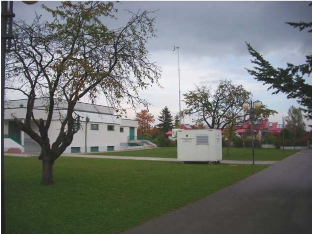
Abbildung 3 Messstandort Richtung Norden
