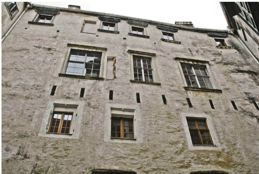
Abb. 10: Burg Schlaining: Hoffassade des „Baumkirchertrakts“. (Foto: Thomas Kühtreiber, 2011)
