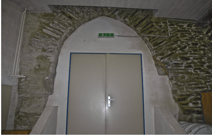
Abb. 14: Burg Schlaining: Tor im Vorburgbering, Ansicht von außen (Foto: Thomas Kühtreiber, 2011)
