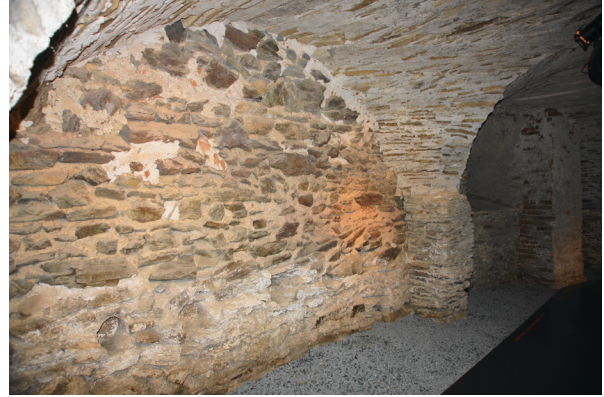
Abb. 3: Burg Schlaining: Lagerhaftes Bruchsteinmauerwerk in der Außenmauer des „Baumkirchertrakts“. (Foto: Gerhard Reichhalter, 2011)
