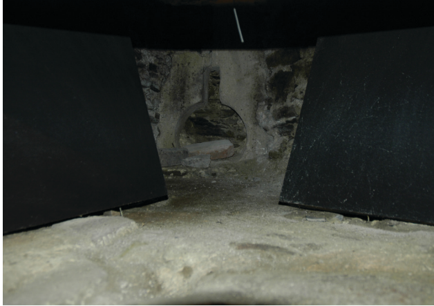
Abb. 7: Burg Schlaining: Schlüsselscharte im Untergeschoß des „Kapellenturms“ von innen (Foto: Thomas Kühnreiter, 2011)
