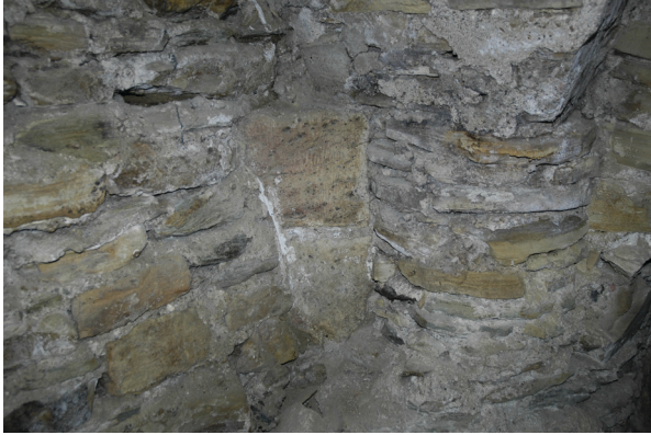
Abb. 2: Burg Schlaining: Quadermauerwerk im hofseitigen Fundament des „Baumkirchertrakts“ (Foto: Thomas Kühnreiter, 2012)
