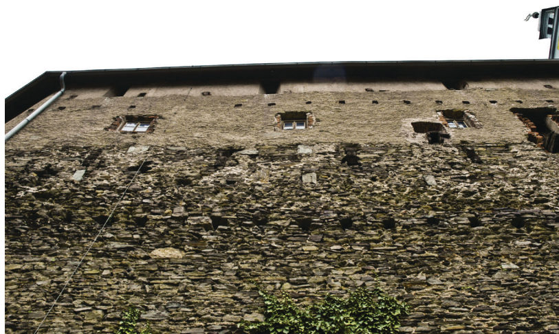
Abb. 5: Burg Schlaining: Außenansicht des Südwest-Berings der Vorburg mit Balken des älteren Außenwehrgangs (Bildmitte, untere Balkenreihe) und jüngerem Außenwehrgang (oberes Bild Drittel, mehrlagige Konsolreihe) (Foto: Thomas Kühtreiber, 2011)
