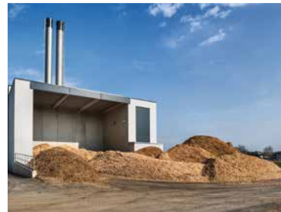
■ Dezentrale Energieproduktion mit Biomasse Foto: act4.energy
