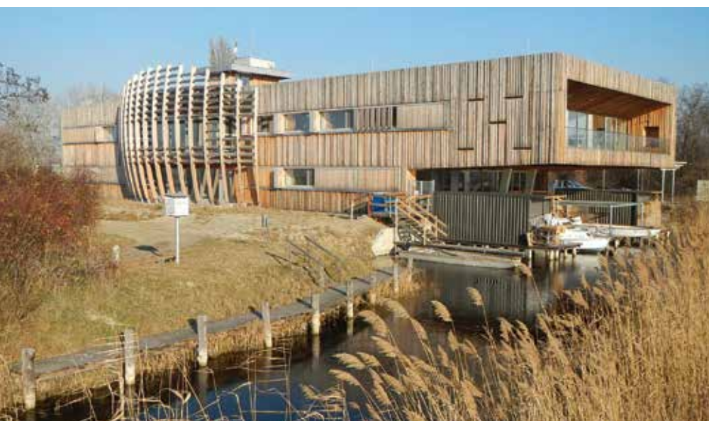
■ Die neu errichtete Biologische Station in Illmitz im Herbst 2015.
