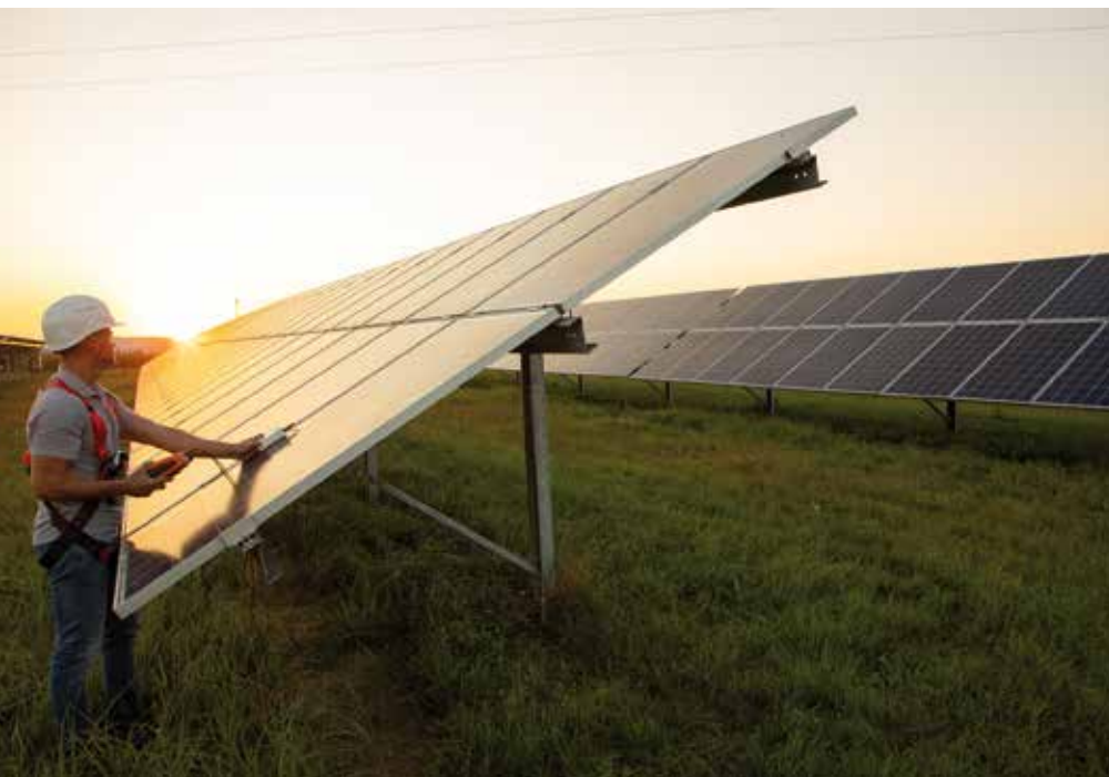
■ Flächen-Photovoltaikanlage in Eisenstadt, Lobäcker – viel Grün, das sich beispielsweise für extensive Beweidung eignet
